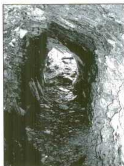
Fig. 10 - Vue intérieure d'une galerie ardoisière dont le toit est parallèle au plan de schistosité (commune de Valjouffrey)
