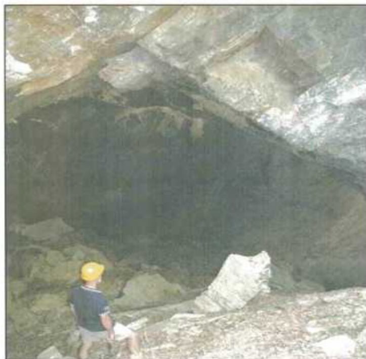
Fig. 9 - Entrée d'une carrière de gypse avec chute de toit (commune de Champ/Drac)
