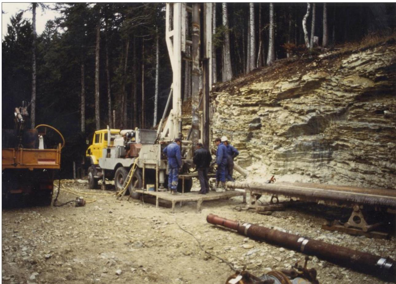
*Photo 33 - Le creusement du puits du captage. Les hommes sont autour du train de tubes équipé d'un marteau trépan en bout. Le trou achevé fera 300 m de profondeur et l'eau sera au rendez-vous !
